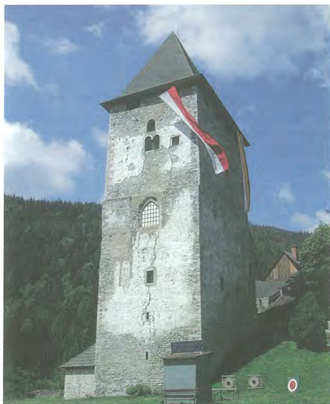
Abb. 5: Mittelalterlicher Bergfried in Friesach.
