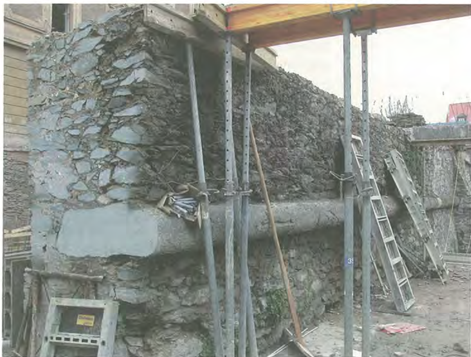
Abb. 8: Renaissancezeitliche Stadtmauer in Klagenfurt während Umbauarbeiten.
